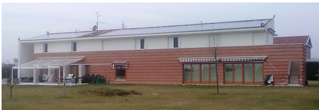
Stato attuale edificio esistente facciata sud
